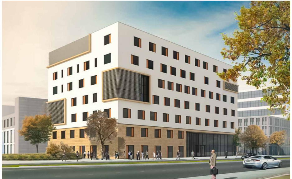
So ist das Haus G von der Ecke Kriegsbergstraße /Herdweg aus geplant
