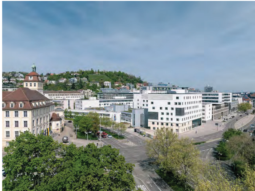
Abb. 1: Luftaufnahme des Neubaus am Klinikum Stuttgart
